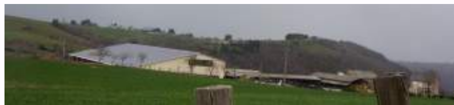
Bâtiment d'élevage plateau du Ségala – Source : E2D, 2016
